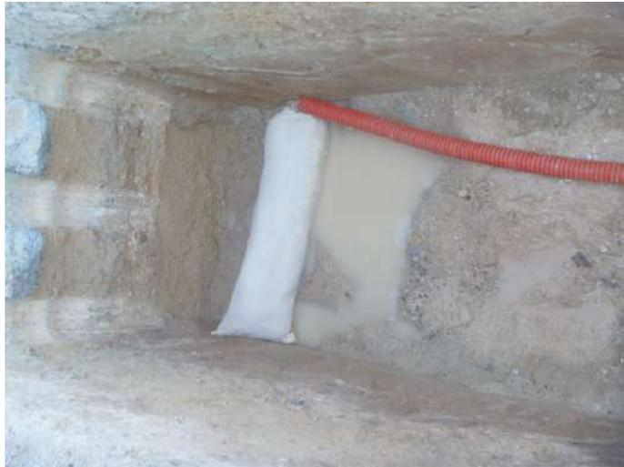
Figure 6 : Mise en place d'une anode magnésium pour limiter les courants vagabonds
