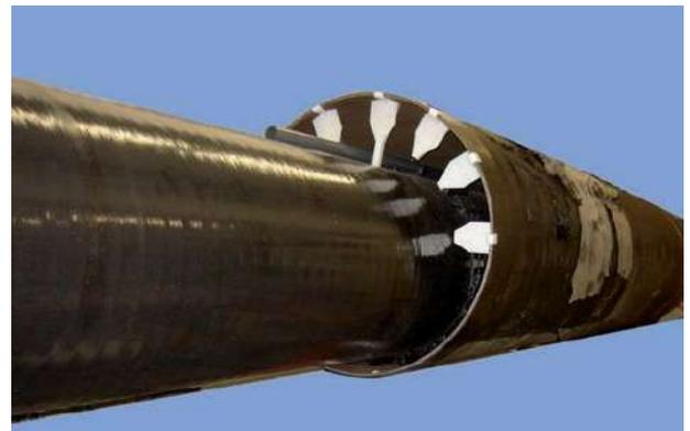
Placer les segments de mousse sur la canalisation et les insérer dans la gaine. Le flasque surélevé repose ainsi sur la face extérieure de la gaine. Cela garantit la sécurité du support.
